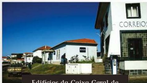
Edifícios da Caixa Geral de Depósitos e dos Correios, no centro da Vila do Corvo.
